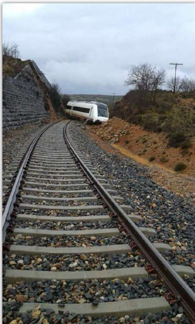
Plataforma en Defensa del Ferrocarril de Teruel. Rotura del revestimiento del talud que afecta a la superestructura, con descarrilamiento de un tren 599 (23/03/2015), entre Rubielos de Mora y Sarrión.
