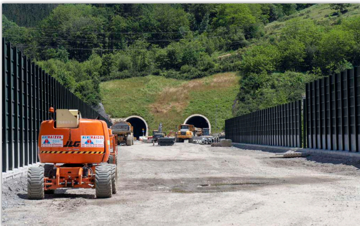
Antonio García-Bykofoto. Túneles y estructuras para salvar las dificultades orográficas.
