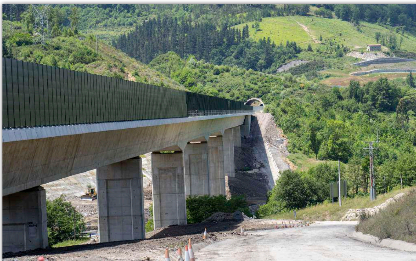
Antonio García-Bykofoto. En territorio accidentado y de gran valor ambiental, sucesión de viaductos y túneles.
