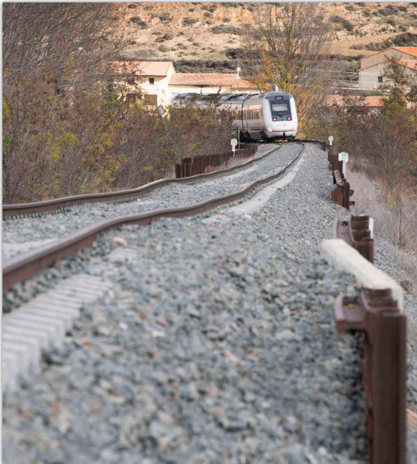
Antonio García-Bykofoto. Deformaciones en la infraestructura que afectan al perfil longitudinal de la superestructura. Deterioro de la nivelación y de la alineación de la vía.
