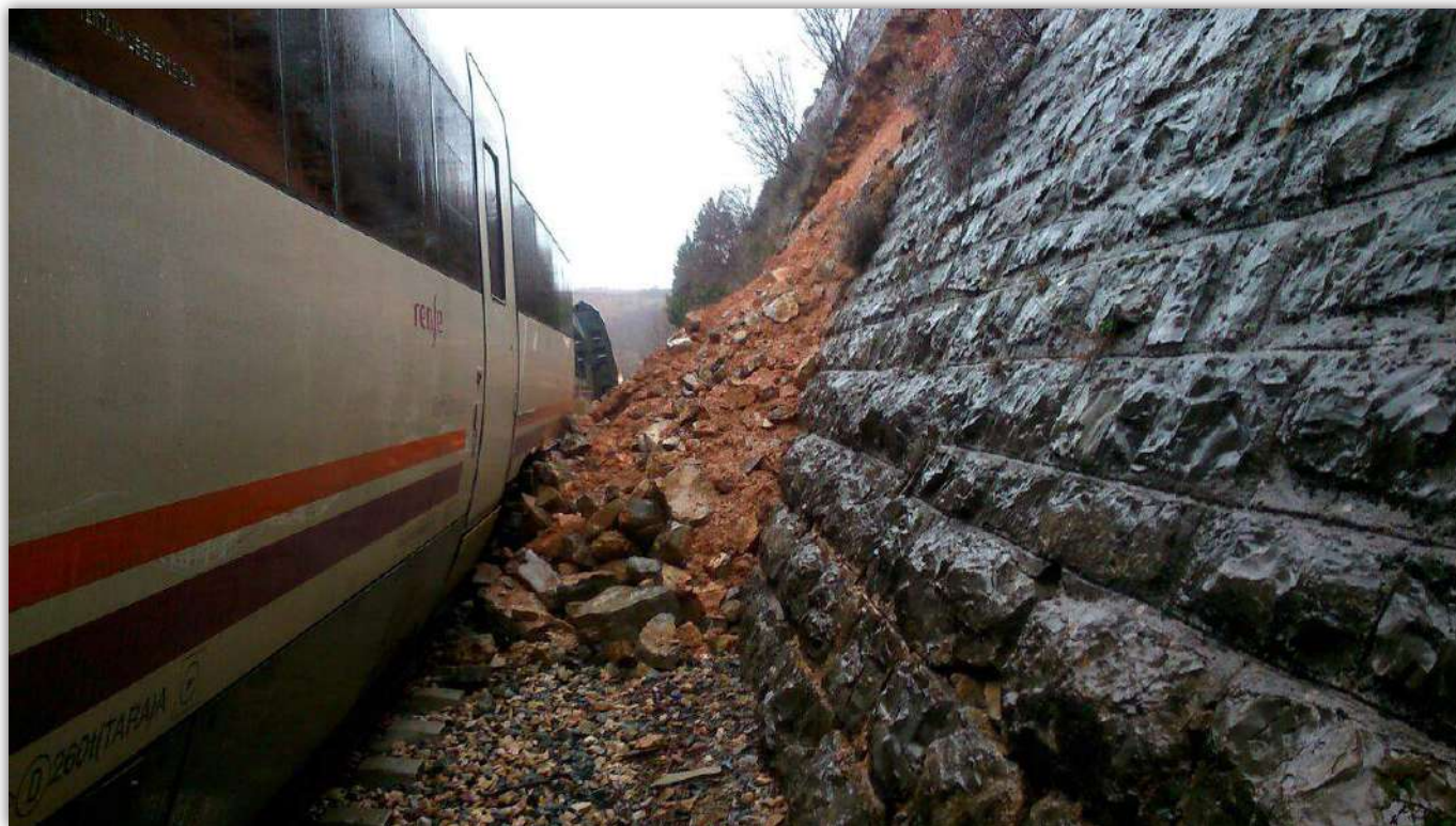
Plataforma en Defensa del Ferrocarril de Teruel. Rotura del revestimiento del talud que afecta a la superestructura, con descarrilamiento de un tren 599 (23/03/2015), entre Rubielos de Mora y Sarrión.
