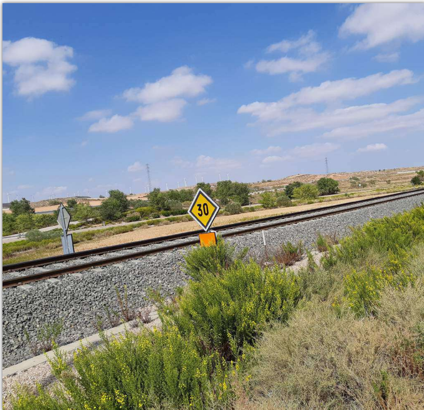
Antonio García-Bykofoto. Escandalosa limitación a 30 km/h. en Arañales de Muel. En teoría, en el tramo de Alta Velocidad Teruel-Zaragoza. Dicha limitación se mantiene desde hace más de 6 años y determina una reducción drástica de la velocidad de los trenes por un problema de 200 metros de un terraplén inestable.
